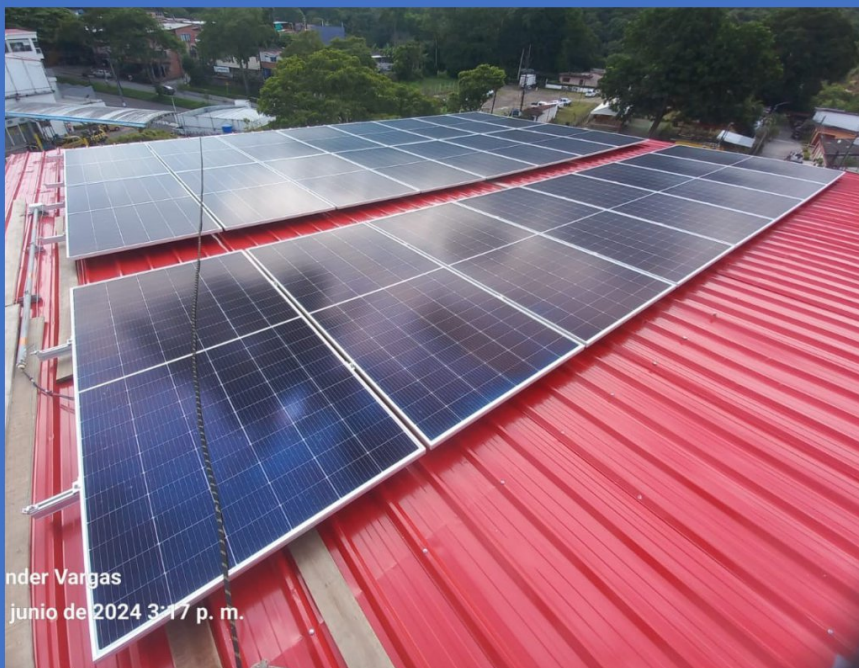
Imagen 6. Módulos fotovoltaicos instalados.
